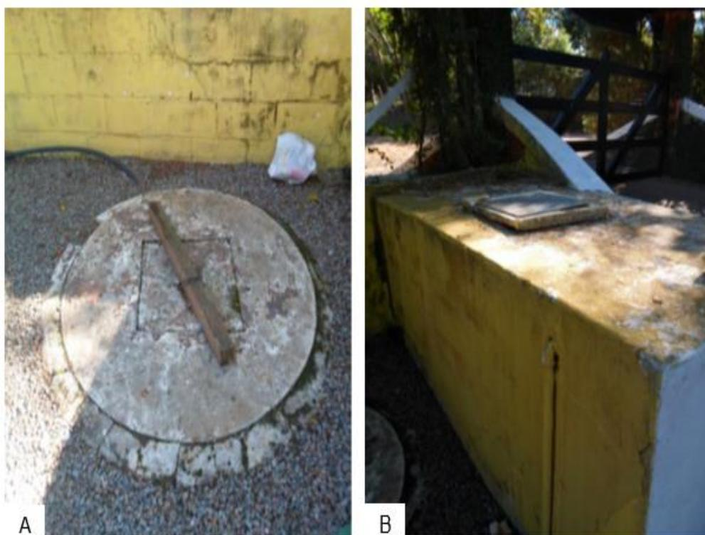
**Figura 22 - Captação subterrânea para abastecimento de água na área rural do município de Cabreúva : a) Poço Cacimba; b) Reservação.**
